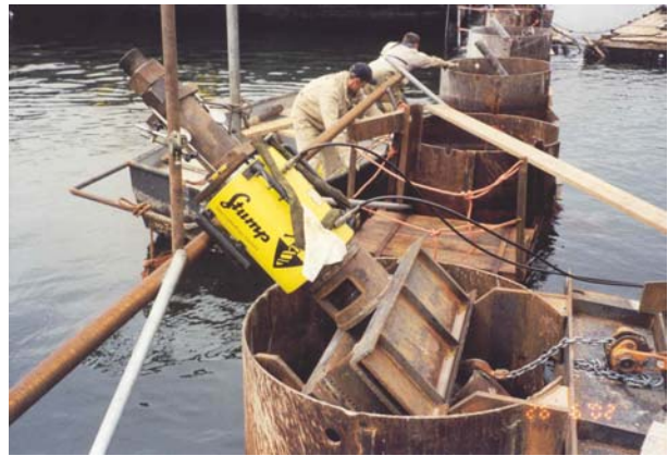
Fig. 7: Prüfeinrichtung mit Messbalken. Fig. 7: Detail of pile testing.
