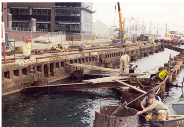
Fig. 6: Aufbau der Probelastung. Fig. 6: Pile test equipment.
