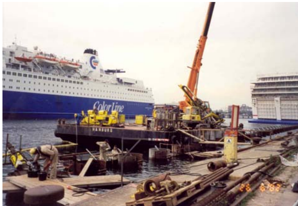
Fig. 5: Geräteeinheit für die Probepfahlherstellung. Fig. 5: Execution of test piles.
