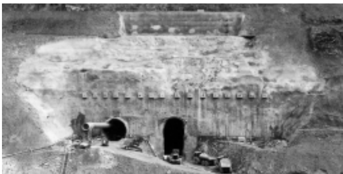
Pumpspeicherwerk Goldisthal, Böschungssicherung am Auslaufbauwerk mit Spritzbeton, Nägeln und Dauerankern
