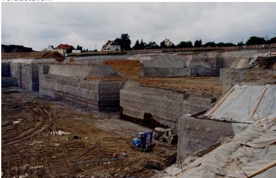
Abbildung 5: Baugrubensicherung Universitätsklinik Würzburg
