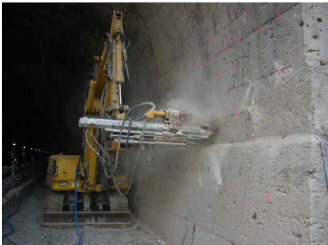
Nach Rückbau eines Gleises wurde bei laufendem eingleisigen Verkehr zunächst im Firstbereich die teilweise vorhandene alte Spritzbetonschale abgefräst und das Mauerwerk sandgestrahlt. Anschließend erfolgte das Bohren der Löcher und Setzen der für die Injektion notwendigen Röhrchen. Nach diesem Arbeitsgang wurde die erste Lage Spritzbeton aufgebracht und die
