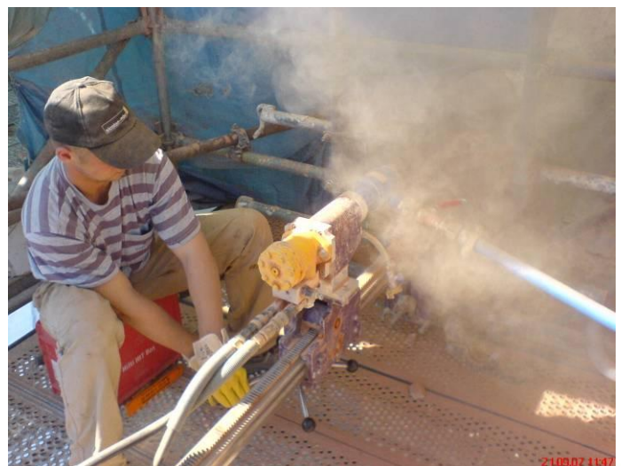
Abb. 3 : Ausführung der Bohrarbeiten
