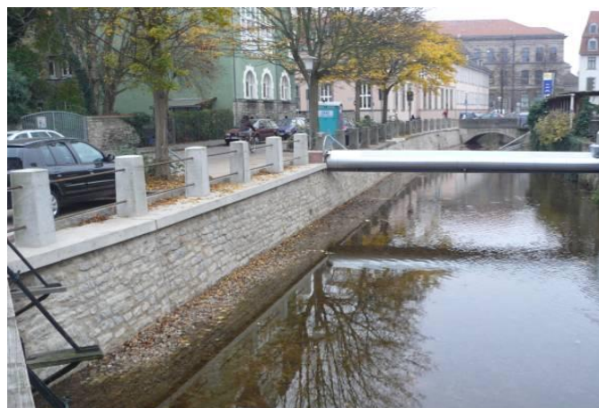
Abb.: Zustand nach der Sanierung
