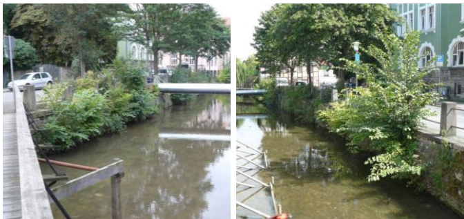
Abb.: Zustand der Ufermauer vor der Sanierung
