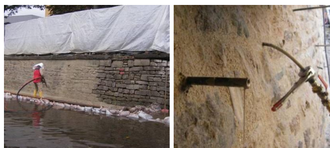
Abb.: Spritzverfugung
