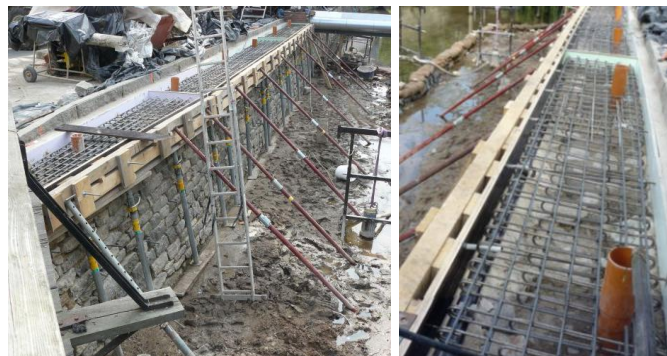
Abb.: Schalung Abdeckplatte Mauerkrone
