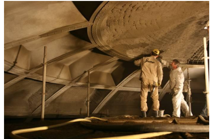
Abb.3 – Auftrag Spritzbeton
