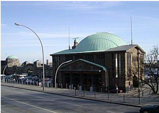
Abb. 1 - Kuppel des Einfahrbauwerk
