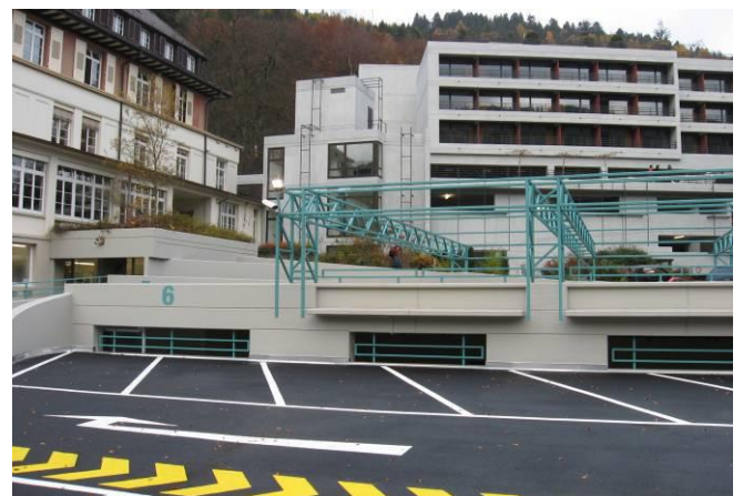
Abb. 2 - Nach erfolgter Instandsetzung
