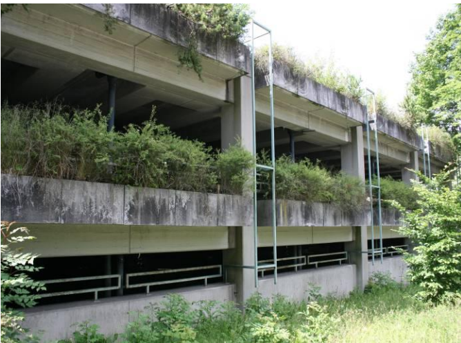
Abb. 1 – Parkhaus vor der Sanierung
