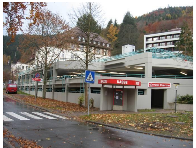
Abb. 2 Parkhaus nach erfolgter Instandsetzung
