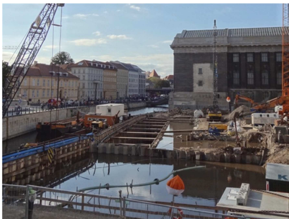
Baugrube Neues Eingangsgebäude September 2012
