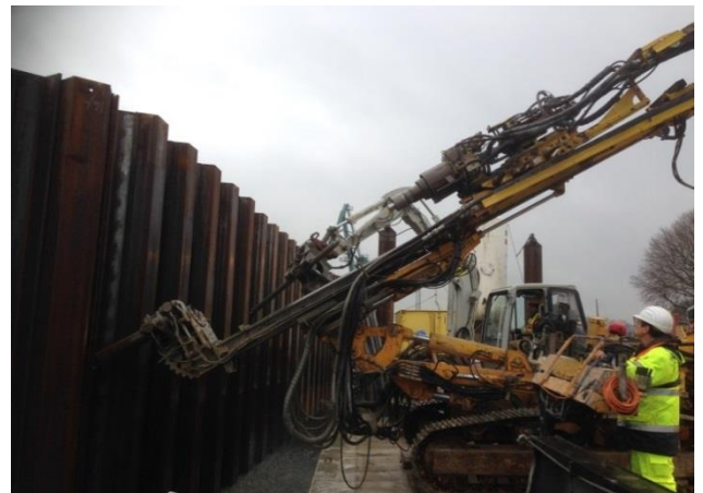
Blick auf das Bohrgerät während der Arbeiten
