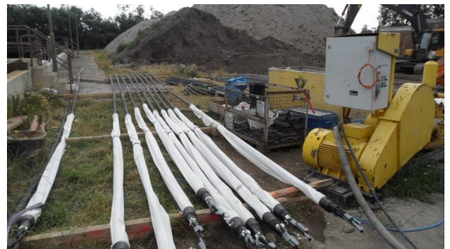
Vorbereitete Pfähle mit Gewebestrümpfen
