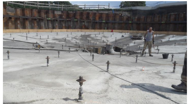
Vorbereitete Pfähle mit Gewebestrümpfen
