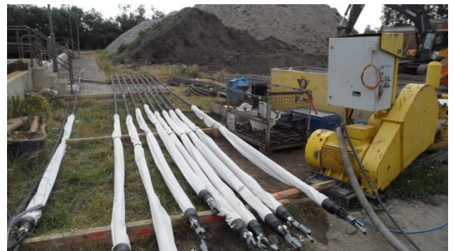
Vorbereitete Pfähle mit Gewebestrümpfen
