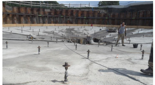
Vorbereitete Pfähle mit Gewebestrümpfen
