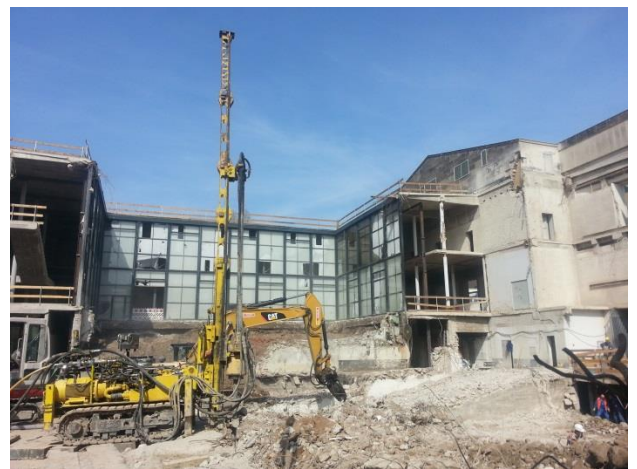
Temporäre Sicherungsmaßnahmen im Innenbereich
