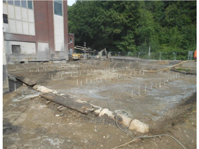
Blick auf das Baufeld kurz vor Fertigstellung der Arbeiten
